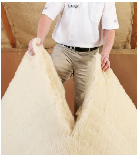
Einlegen der Dämmmatte in die Konstruktion antackern der Matten an die Holzkonstruktion
