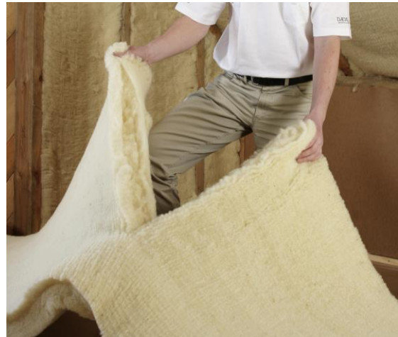
Einlegen der Dämmmatte in die Konstruktion antackern der Matten an die Holzkonstruktion
