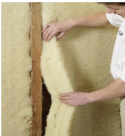
Einlegen Dämmmatten DWS12
